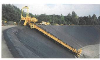
Bild 9. Brückenfertiger im Einsatz beim Pumpspeicherbecken Glems, 1996.
