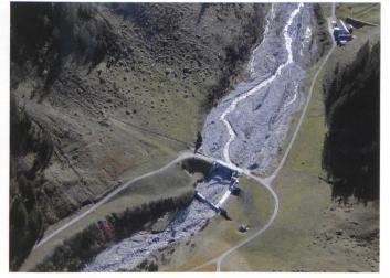
Bild 4. Die Fassung Durnagelbach, eine andere der 25 Fassungen der Kraftwerke Linth-Limmern, musste im Rahmen der Sanierung nach Art. 80 GSchG nicht dotiert werden, nach dem Beginn der neuen Konzession muss gestützt auf die Schutzund Nutzungsplanung kein Dotierwasser abgegeben werden. Ein wichtiger Grund für diese Nulldotierung ist der ökologisch wenig bedeutsame, vollständig verbaute Gewässerabschnitt unterhalb der Fassung, der kein Fischgewässer darstellt.
