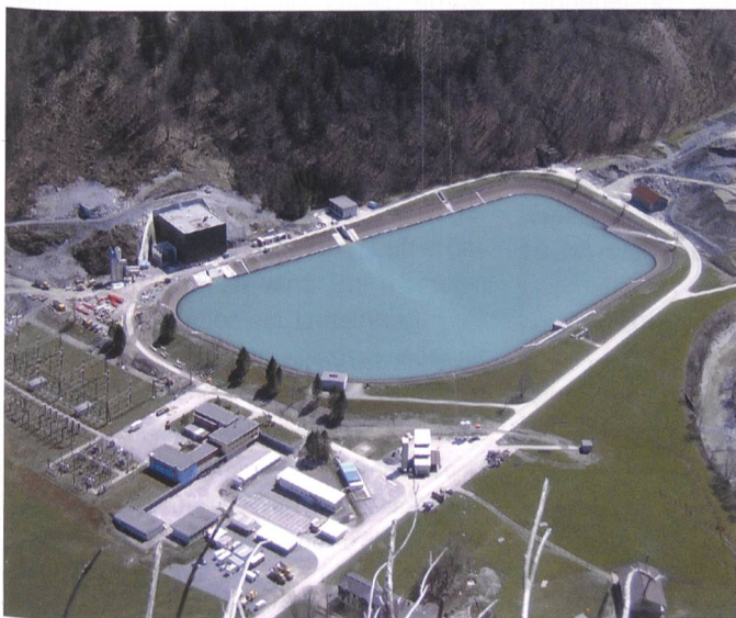
Bild 7. Die Kraftwerke Linth-Limmern verfügen jetzt schon über grosse Ausgleichsbecken bei der untersten Zentrale in Linthal vor der Abgabe in die Linth, im Tierfehd (s. Bild) und auf Hintersand.
