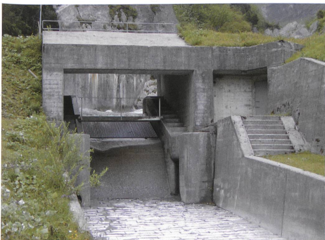
Bild 3. Die Fassung Wichlenbach ist eine der 25 Fassungen der Kraftwerke Linth-Limmern. Diese wird im Rahmen der Sanierung nach Art. 80 GSchG ab dem 1. Juli 2008 mit 60 l/s und ab dem Beginn der neuen Konzession (1. Dez. 2016) gemäss den Vorgaben von Art. 32 des Gewässerschutzgesetzes mit 83 l/s dotiert.
