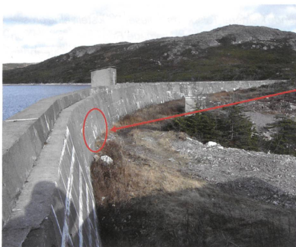
Figures 1 et 2. Barrage du Goéland à Saint-Pierre et Miquelon ( H = 6 \text{ m} , 400\,000 \text{ m}^3 ) avant sa reconstruction fin 2007. À droite, zone du parement aval siège de suintement et fortement dégradée par le gel. La stabilité de ce barrage était fortement compromise par la poussée des glaces.
