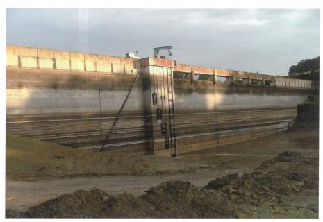
Figure 5. Parement amont du barrage de Bois Joli (H = 24 m, 3 hm³) lors du récent examen décennal complet.
