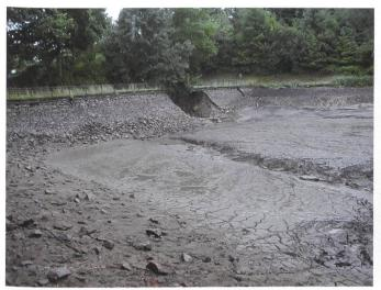
Figure 3. Barrage des Ouches (H = 7 m, 49000 m³), victime d'une rupture par érosion interne, deux siècles après sa construction. Il n'y a pas eu de victimes dans le village situé 4 km en aval grâce à ses petites dimensions mais aussi grâce à la présence d'esprit de l'exploitant qui a rapidement prévenu la gendarmerie qui a demandé aux personnes présentes dans les rues un dimanche matin de se mettre à l'abri.
