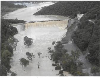
Figure 4. Barrage écrêteur de crue de la Rouvière (H = 18 m, 8.3 hm³) lors de la crue du 9 septembre 2002. Ce barrage, construit en 1970, a connu ce jour là une crue supérieure à sa crue de sûreté et s'est malgré cela bien comporté.
