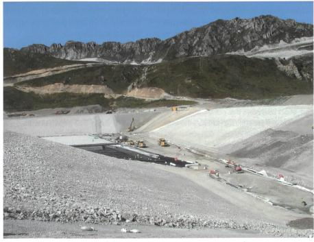
Figure 7. Chantier du barrage d'altitude des Arcs (17 m, 4000000 m³). Ici, la complexité de la géologie et le risque de développement d'une érosion interne dans des cargneules a justifié la pose d'une double géomembrane pour une grande partie de la retenue (diverses couches de cette étanchéité et de sa couverture de protection sont en cours de pose).
