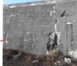
Figures 1 et 2. Barrage du Goéland à Saint-Pierre et Miquelon (H = 6 m, 400000 m³) avant sa reconstruction fin 2007. À droite, zone du parement aval siège de suintement et fortement dégradée par le gel. La stabilité de ce barrage était fortement compromise par la poussée des glaces.
