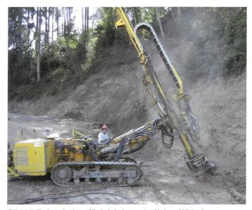
Bild 15. Bohrarbeiten für Injektionen im linken Widerlager.
