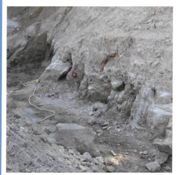
Bild 13. Offene Klüfte/Hohlräume im Bereich der linken Kernaufstandsfläche.
