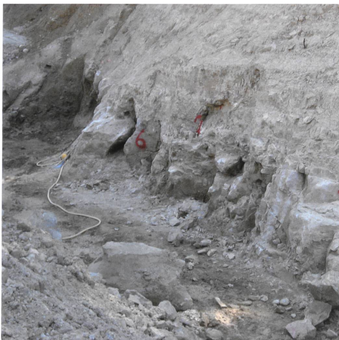
Bild 13. Offene Klüfte/Hohlräume im Bereich der linken Kernaufstandsfläche.
