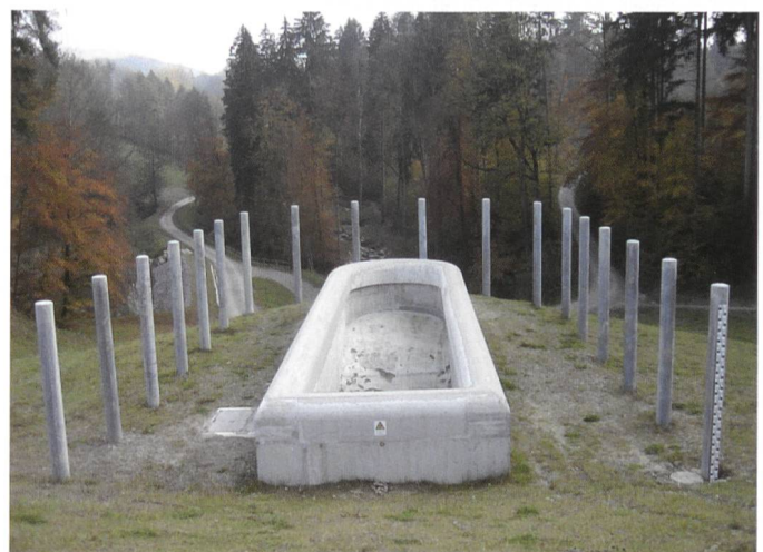
Bild 8. Hochwasserentlastung mit vorgelagertem Schwemmholzrechen.
