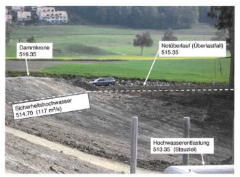
Bild 10. Erhöhte Dammsicherheit mit zusätzlichem Notüberlauf im Überlastfall.
