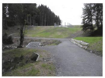
Bild 9. Wasserseitige Böschung mit Einlaufpartie und Hochwasserentlastung.
