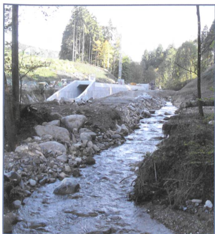
Bild 11. Baumleitung mit Durchlassbauwerk im Oktober 2005.
