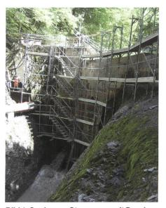
Bild 1. Sanierung Staumauer mit Druckleitung und Grundablass.
