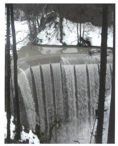
Bild 3. Überfall-Staumauer bei Hochwasser.
