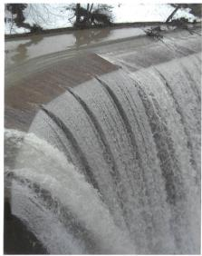
Bild 2. Überfall-Staumauer bei Hochwasser (Detail).
