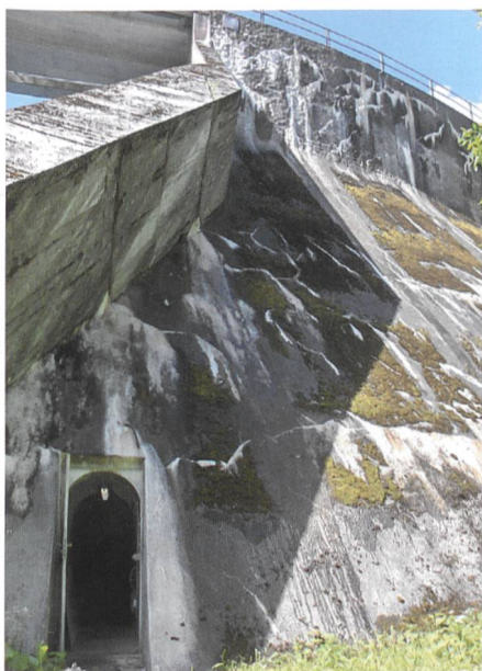
Bild 5. Oberflächenschäden, Stauwehr Egschi.
