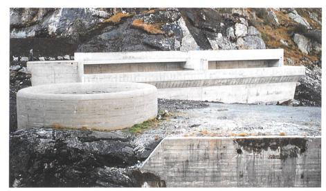
Bild 12. Zusätzliche Hochwasserentlastung, Stauanlage Zött.
