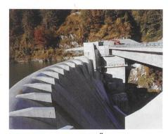
Bild 8. Umgebauter HW-Überfall Palagnedra.
