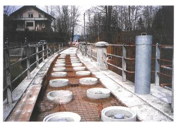
Bild 4. Kronenbalken mit Ankerköpfen, Gübsenseemauer.
