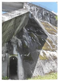
Bild 5. Oberflächenschäden, Staumauer Egschi.
