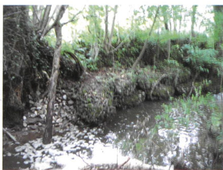
Bild 9. Beispiele für typische Mängel bei kleineren Stauanlagen: a) oben links, verstopfungsanfälliger Weiherauslauf mit Feinrechen und Ableitung in einem Rohr, b) oben rechts, beschädigte Ufersicherung eines Hochwasserableitungsgerinnes, c) unten links, lokal stark durchsickerte Damm und Wasseraustritt auf der luftseitigen Dammböschung, d) unten rechts, erodierter Damm entlang eines Bachs mit beschädigten Drahtschotterkörben am Dammfuss.
