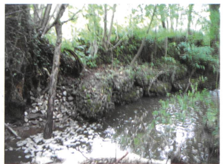
Bild 9. Beispiele für typische Mängel bei kleineren Stauanlagen: a) oben links, verstopfungsanfälliger Weiherauslauf mit Feinrechen und Ableitung in einem Rohr, b) oben rechts, beschädigte Ufersicherung eines Hochwasserableitungsgerinnes, c) unten links, lokal stark durchsickerter Damm und Wasseraustritt auf der luftseitigen Dammböschung, d) unten rechts, erodierter Damm entlang eines Bachs mit beschädigten Drahtschotterkörben am Dammfuss.
