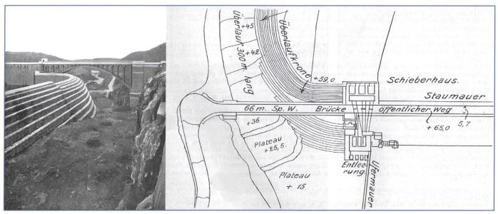
Bild 6. New Croton Staumauer, Hochwasserentlastung (a) Blick in Fliessrichtung (Mattern 1913), (b) Grundriss.
