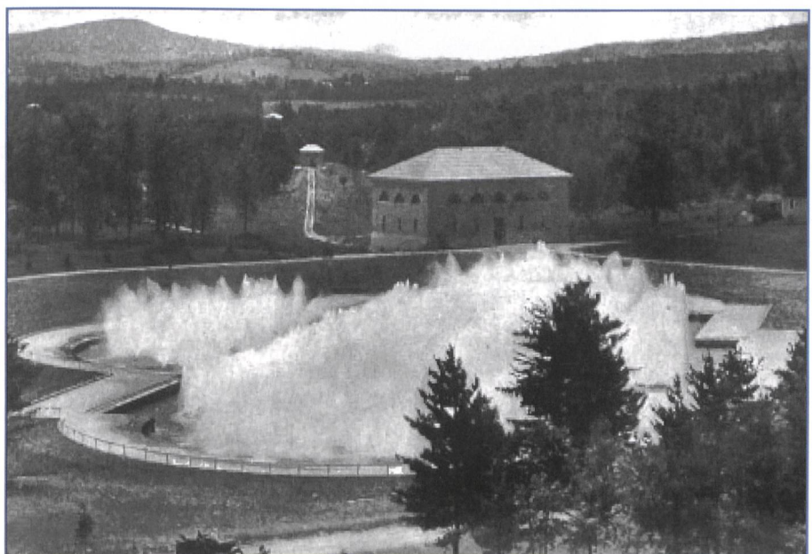
Bild 10. Ashokan Belüfter des Catskill Aqueduct.
