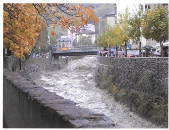
Bild 5. Die Saltina während des Hochwassers vom 15. Oktober 2000 in Brig (Kt. Wallis). Die im Anschluss an die schweren Verwüstungen vom 24. September 1993 ausgeführten baulichen Schutzmassnahmen (z.B. Hubbrücke, demontierbare Stege) bewährten sich: die Stadt Brig-Glis blieb im Oktober 2000 von Überflutungen und Geschiebeablagerungen weitgehend verschont (Foto: Ingenieurbüro wasser/schnee/lawinen, Brig-Glis).
