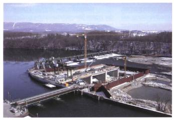
Bild 16. Fertig gestellte Wehrfelder sieben, sechs, fünf und Wehrzentrale.
