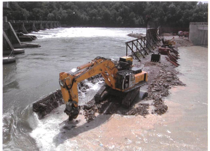
Bild 17. Rückbau der Baugrubenumschliessung, erste Baugrube.
