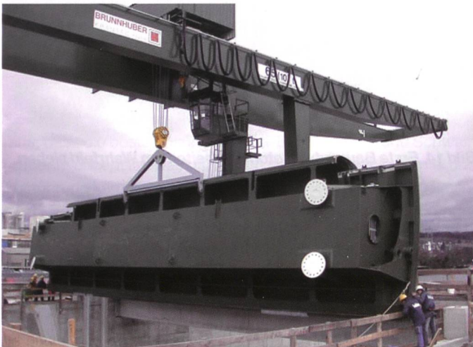
Bild 15. Montage einer Segmentschütze mit dem neuem Portalkran.
