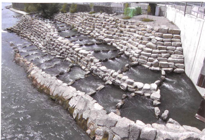
Bild 25. Neuer Raugerinnebeckenfischpass an der bestehenden Kanalmauer.
