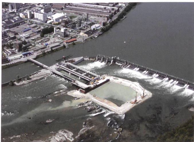
Bild 19. Schüttdamm zum Bau der Umschliessung von Baugrube zwei.
