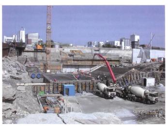
Bild 14. Erste Baugrube, Betonierarbeiten am Wehrfeld sieben.
