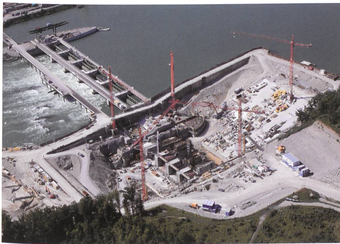
Bild 31. Mit den Betonierarbeiten wurde im Februar 2008 begonnen, die ersten Saugrohrpanzerungen wurden eingebracht.
