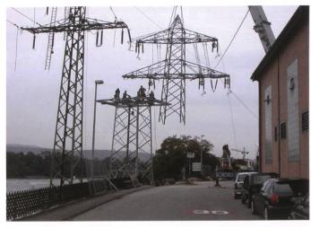
Bild 6. Verlegung der 110-kV-Leitungsmasten.
