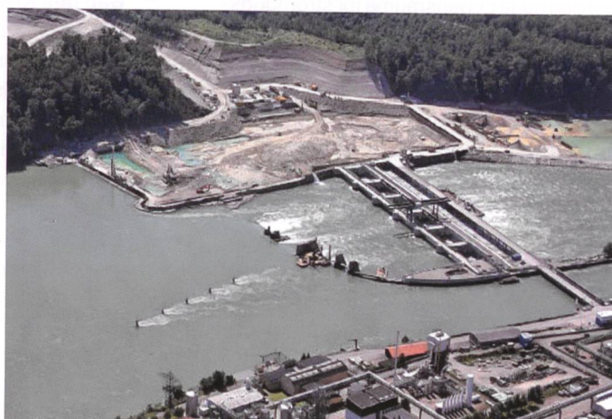
Bild 22. Baugrubenumschliessung Maschinenhaus fertig gestellt, Stau auf neues Stauwehr verlegt.
