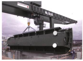
Bild 15. Montage einer Segmentschütze mit dem neuem Portalkran.
