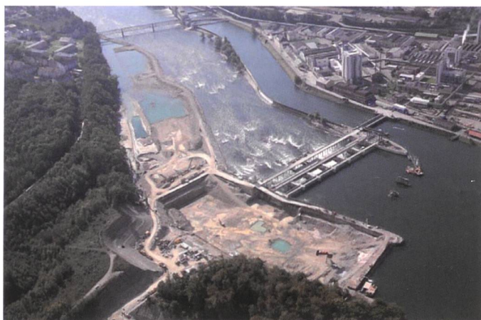
Bild 23. Beginn Abbruch altes Stauwehr, Baugrube Maschinenhaus bereit für Aushub.
