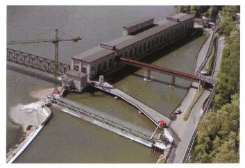
Bild 3. Neue Grobrechenanlage am bestehenden Kraftwerk.
