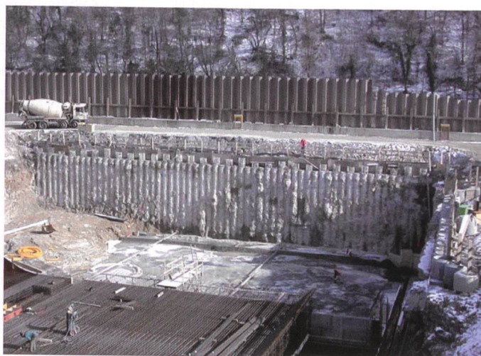
Bild 21. Sicherung der Baugrube zwei mit einer armierten Bohrpfeilwand.
