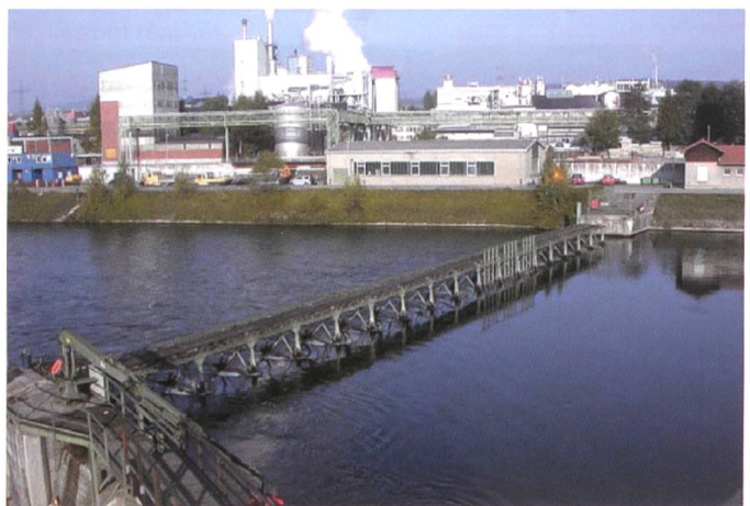
Bild 4. Rückbau alter Grobrechen am Oberwasser-Kanaleinlauf.
