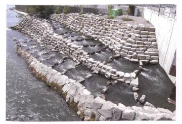
Bild 25. Neuer Raugerinnebeckenfischpass an der bestehenden Kanalmauer.
