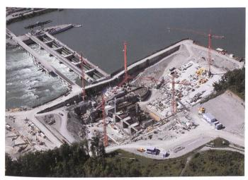
Bild 31. Mit den Betonierarbeiten wurde im Februar 2008 begonnen, die ersten Saugrohrpanzerungen wurden eingebracht.
