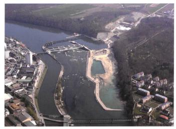
Bild 30. Beginn der Rheineintiefung im Schutze eines Schüttdammes.
