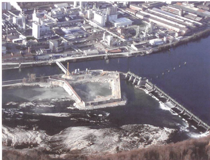
Bild 13. Fertiggestellte Umschliessung der Baugrube eins vor der Entleerung.
