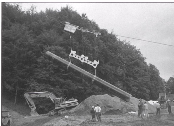
Transport und Versetzen Erdgasleitung, Rohrgewicht 12 Tonnen
