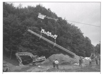
Transport und Versetzen Erdgasleitung, Rohrgewicht 12 Tonnen
