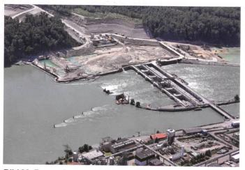
Bild 22. Baugrubenumschliessung Maschinenhaus fertig gestellt, Stau auf neues Stauwehr verlegt.
