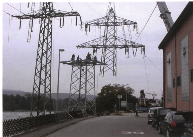
Bild 6. Verlegung der 110-kV-Leitungsmasten.
