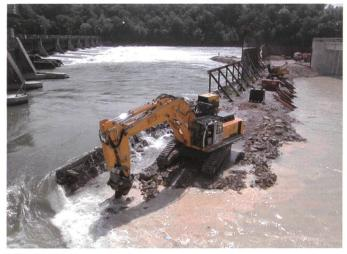
Bild 17. Rückbau der Baugrubenumschliessung, erste Baugrube.
