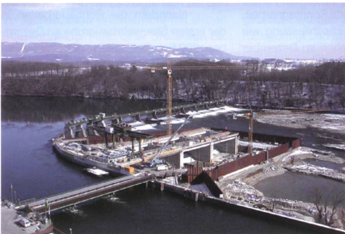
Bild 16. Fertig gestellte Wehrfelder sieben, sechs, fünf und Wehrzentrale.
