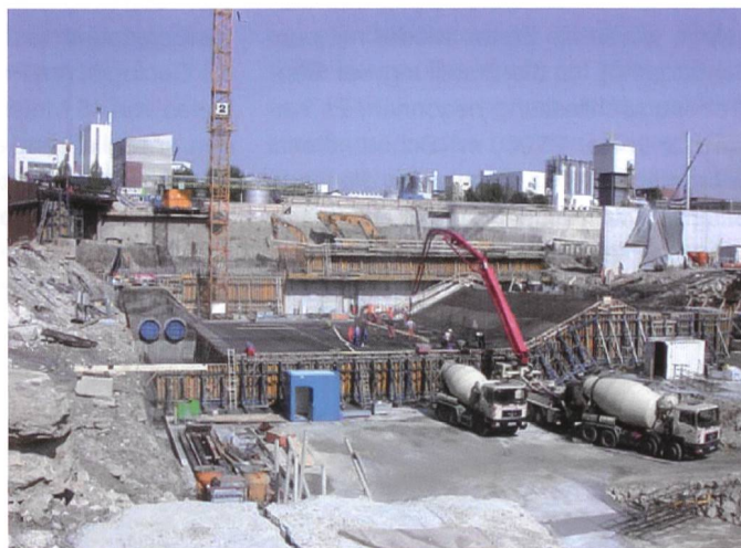
Bild 14. Erste Baugrube, Betonierarbeiten am Wehrfeld sieben.
