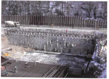
Bild 21. Sicherung der Baugrube zwei mit einer armierten Bohrpfahlwand.
