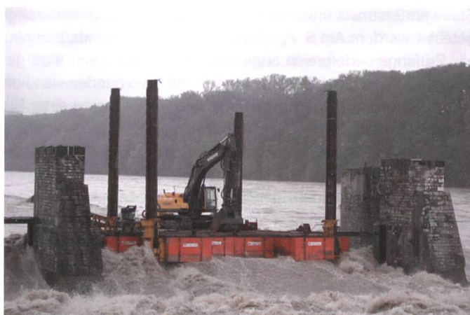
Bild 24. Abbruch altes Stauwehr, Ponton mit Abbruchbagger bei Hochwasser.
