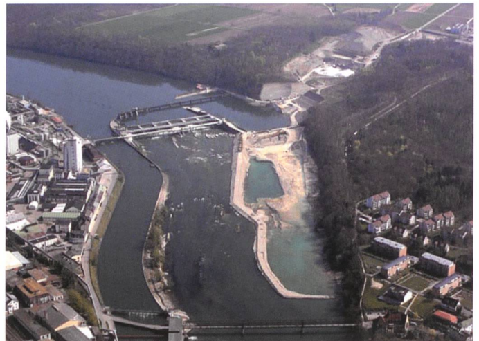
Bild 30. Beginn der Rheineintiefung im Schutze eines Schüttdammes.
