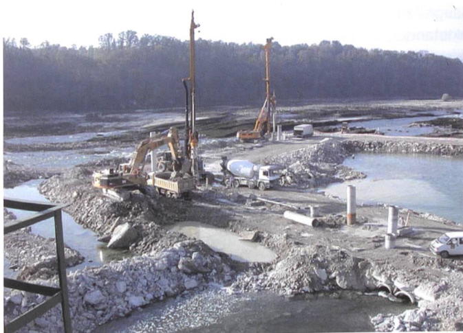
Bild 12. Schüttung der ersten Baugrube für Erstellung der Spundwand.
