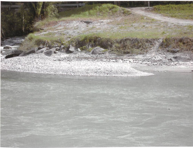
Figure 15. Marnage de la retenue, contraintes sur les berges.
