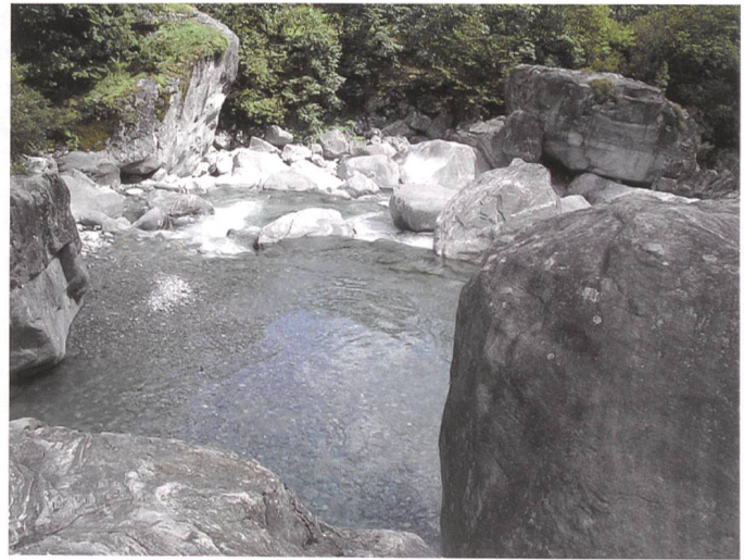
Figure 16. Rivière à poissons construite de façon «naturelle».
