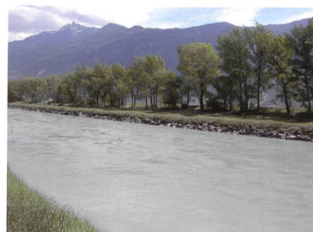
Figure 3. Le Rhône endigué à l'amont de Martigny.
