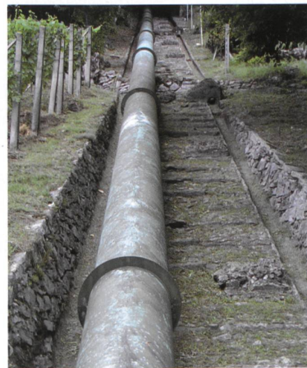
Bild 2. Wasserdruckleitung: verbreitet deutliche Degradation der Korrosionsschutzbeschichtung.
