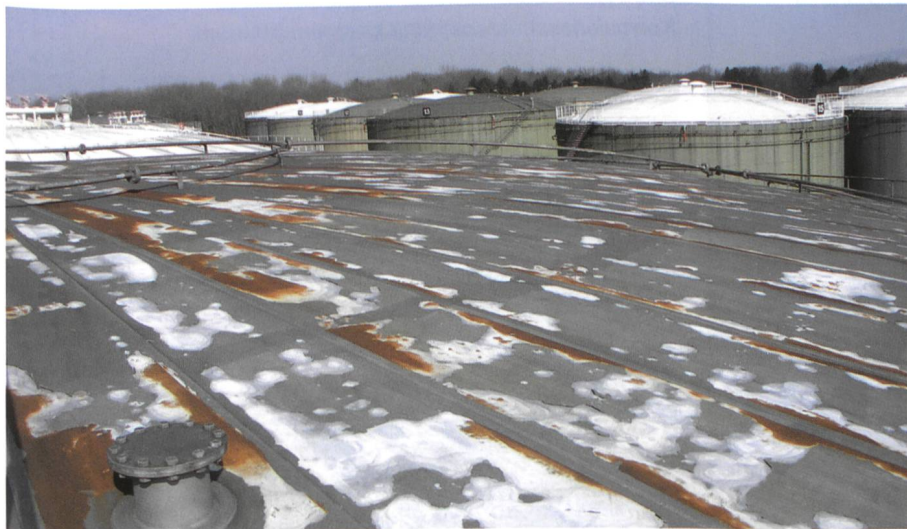
Bild 1. Treibstoff-Stehtank, zonenweise komplette Degradation der Korrosionsschutzbeschichtung.
