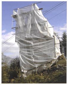
Bild 3. Einhausung von Seilbahnmasten.
