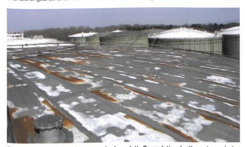
Bild 1. Treibstoff-Stehtank, zonenweise komplette Degradation der Korrosionsschutzbeschichtung.
