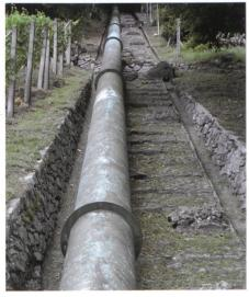
Bild 2. Wasserdruckleitung: verbreitet deutliche Degradation der Korrosionsschutzbeschichtung.
