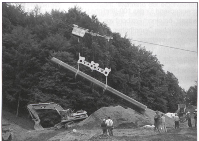
Transport und Versetzen Erdgasleitung, Rohrgewicht 12 Tonnen
