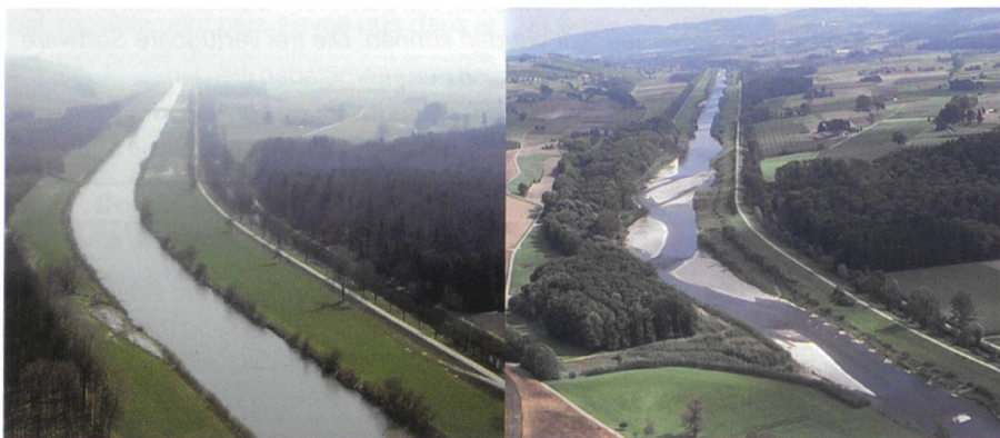
Bild 1. Die Thur bei Altikon: Links nach der Korrektur des 19. Jahrhunderts, rechts nach der Aufweitung des Hauptgerinnes. Schon zwei Jahre nach der Revitalisierungsmassnahme hat sich die morphologische Vielfalt deutlich verbessert.
