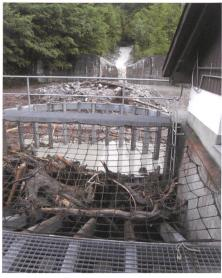
Bild 5. Der Geschiebesammler des Erlenbachs (Alptal, Kt. Schwyz) nach dem Hochwasserereignis vom 20. Juni 2007 (Foto Ch. Rickli). Während des Ereignisses mit einem Spitzenabfluss von rund 16 m³/s wurden etwa 1650 m³ Geschiebe abgelagert (siehe auch Bild 6a).
