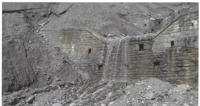
Bild 9. Erosion der seitlichen Flanke durch eine Kombination aus Mechanismus 1A und 3.
