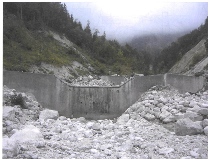
Bild 11. Bruch im Flügel aufgrund fehlender seitlicher Einbindung durch Umgehung.
