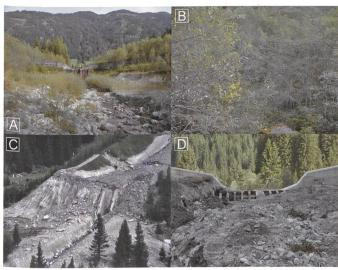
Bild 22. Zustände von Retentionsräumen: (A) plangemäss; (B) Bewuchs mit Grauerlen; (C) Überlastung durch Geschiebe; (D) gefüllter Retentionsraum aufgrund Verklausung des Rechens mit Wildholz (Quelle Bild C, D: IAN [5]).
