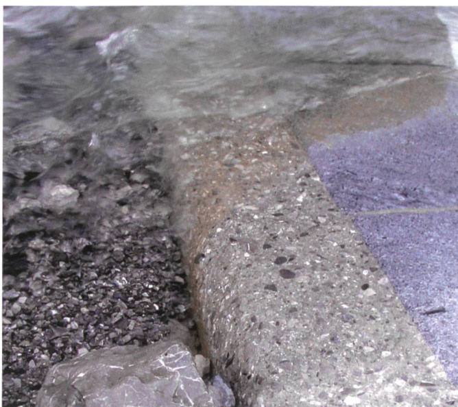
Bild 13. Leichter Abtrag infolge Hydroabrasion (waschbetonartige Oberfläche).
