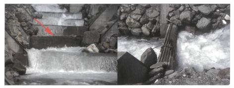
Bild 27. Unterströmung einer Konsolidierungssperre (Quelle: IAN [5]).
