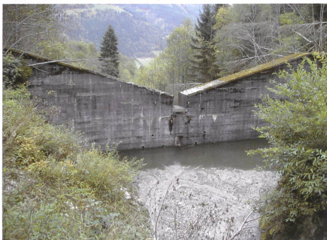
Bild 19. Fehlende Verlandung hinter einer Konsolidierungssperre.
