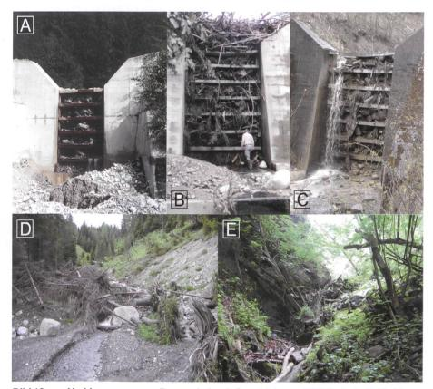
Bild 16 a-c. Verklausungen am Bauwerk durch Geschiebe und Wildholz; D, E: Verklausung im Gerinne; (Quelle Bild A, B, C: IAN [5]).
