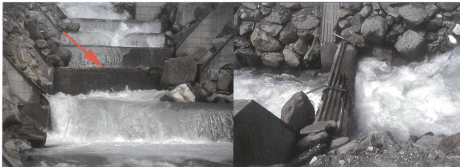
Bild 27. Unterströmung einer Konsolidierungssperre (Quelle: IAN [5]).
