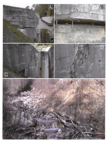
Bild 25. seitlicher Hangdruck: 1. Mechanismus: (A) Abscheren des Flügels an einer horizontalen Fuge (Trennriss) mit anschliessender Verkantung; (B) gerissene Bewehrung; 2. Mechanismus: (C) Abscheren mit Verkantung und Verdrehung; (D) ausgeknickte Bewehrung; (E) 3. Mechanismus: Linksufrige Rutschung schiebt sich bis zur Gerinnemitte vor, ohne das Bauwerk zu zerstören (Quelle Bild C, D, E: IAN [5]).
