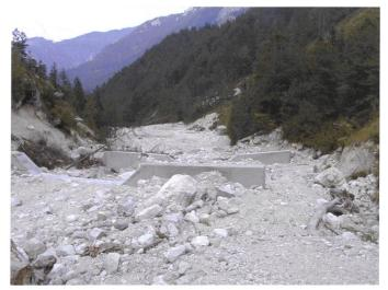
Bild 10. Umgehung von Konsolidierungssperren, aufgrund ungünstiger Anordnung zur Bachachse (Quelle: IAN [5]).
