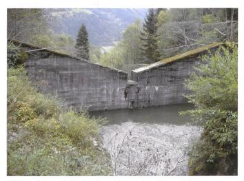
Bild 19. Fehlende Verlandung hinter einer Konsolidierungssperre.
