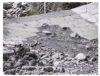
Bild 14. Abtrag von Kronsteinen aus der Abflusssektion infolge Hydroabrasion und Schleppspannung des Wassers.
