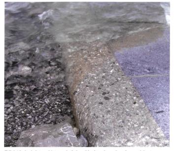
Bild 13. Leichter Abtrag infolge Hydroabrasion (waschbetonartige Oberfläche).
