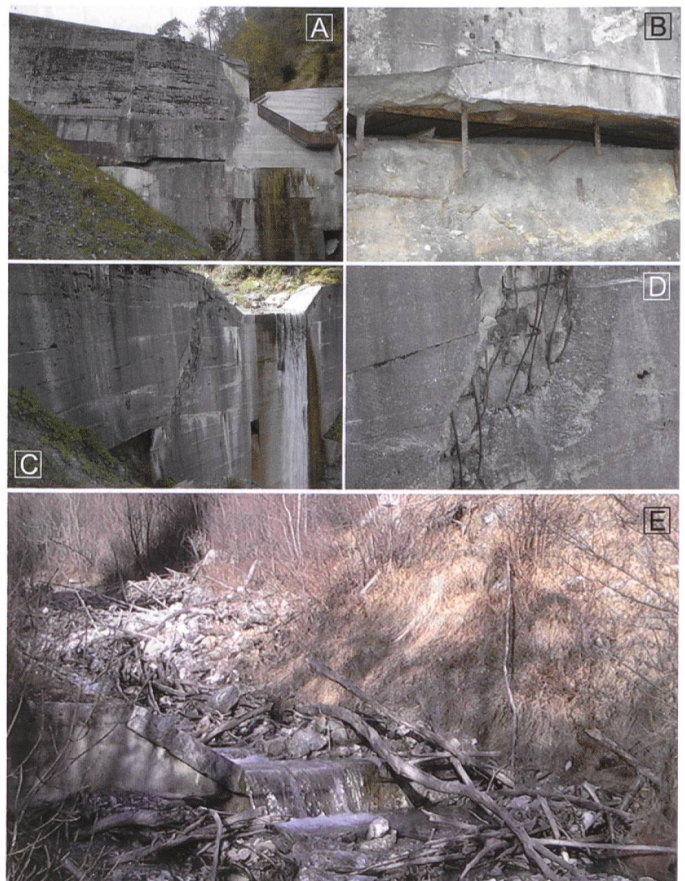
Bild 25. seitlicher Hangdruck: 1. Mechanismus: (A) Abscheren des Flügels an einer horizontalen Fuge (Trennriß) mit anschliessender Verkantung; (B) gerissene Bewehrung; 2. Mechanismus: (C) Abscheren mit Verkantung und Verdrehung; (D) ausgeknickte Bewehrung; (E) 3. Mechanismus: Linksufrige Rutschung schiebt sich bis zur Gerinnemitte vor, ohne das Bauwerk zu zerstören (Quelle Bild C, D, E: IAN [5]).
