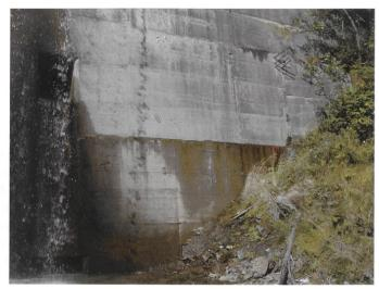
Bild 15. Durchfeuchtung des Betonkörpers entlang ungenügend abgedichteten Arbeitsfugen.
