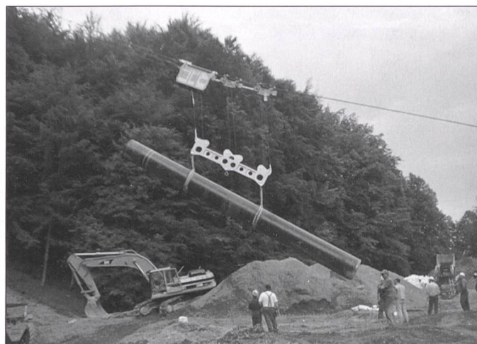
Transport und Versetzen Erdgasleitung, Rohrgewicht 12 Tonnen
