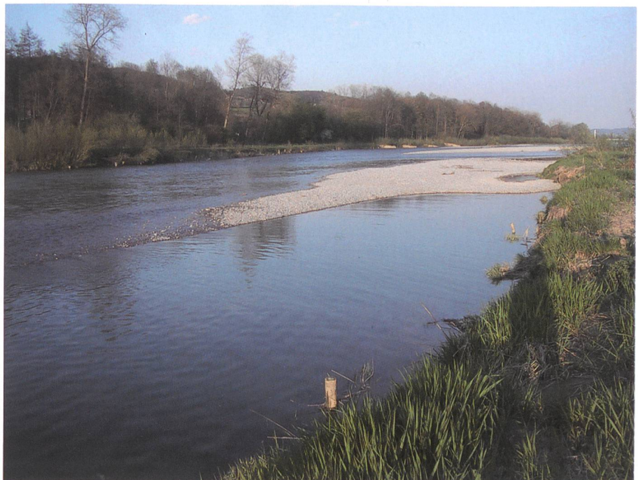
Bild 8. Gerinneaufweitung der Thur bei Niedererneunform.
