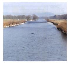
Bild 7. Unterlauf: Doppeltrapezprofil mit kleiner Aufweitung.
