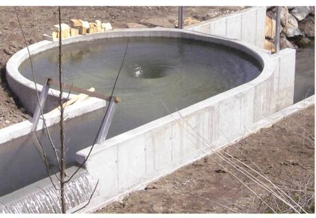
Bild 1. Gravitationswasserwirbel mit 5,5 m Durchmesser.
