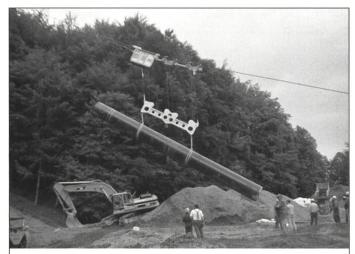
Transport und Versetzen Erdgasleitung, Rohrgewicht 12 Tonnen
