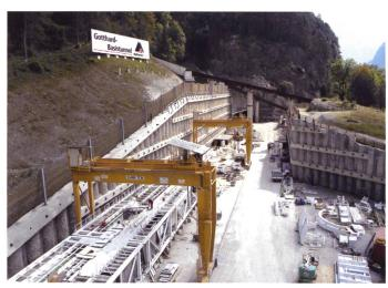
Bild 9. Teilabschnitt Erstfeld: Voreinschnitt.
