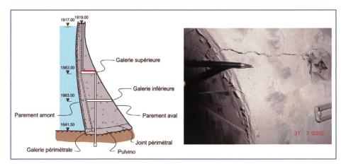
Figure 3. Fissure dans la galerie supérieure.
