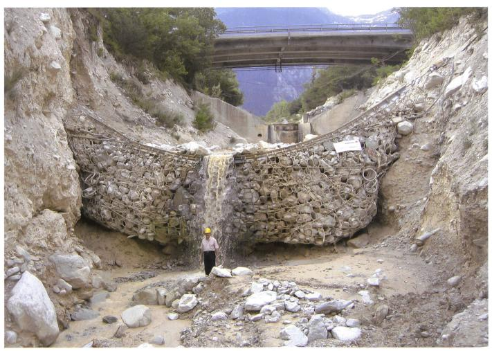
Bild 5. Feldversuch Illgraben, Wallis: 18. Mai 2006, total 15000 m<sup>3</sup> Geschiebe, davon 1000 m<sup>3</sup> zurückgehalten, der Rest überströmte die hinterfüllte Barriere.
