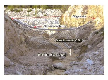
Bild 6. Dimensionierungsgrössen Maschenweite und Basaldurchlasshöhe. Beachte Flügelseile und Abrasionsschutz.
