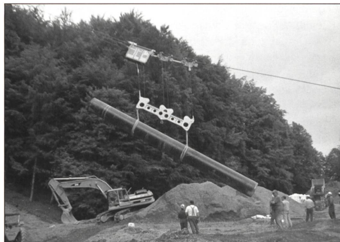
Transport und Versetzen Erdgasleitung, Rohrgewicht 12 Tonnen
