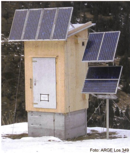
Bild 6. Solarstromversorgung für automatischen Tachymeter.
