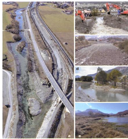
Bild 16. Die En-Ausleitung: Die neue Gestalt des En unterhalb von Samedan: a) Verlauf der En-Ausleitung von Fussgängerbrücke bis Kantonsstrassenbrücke (nach der Flutung, Nov. 2005); b) Moment der En-Ausleitung am 22. September 2005; c) leerer ehemaliger En-Kanal nach Ausleitung; d) eines der als Insel erhaltenen Uferstücke des ehemaligen En-Altlaufs; e) rechtes, erhaltenes Ufer des ehemaligen En-Altlaufs.
