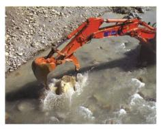
Bild 5. Ökologische Baubegleitung: Der ökologische Baubegleiter ist am Bau mit weitreichenden Befugnissen ausgestattet. So gibt er der Bauleitung und dem Baggerführer konkrete Anweisungen zur Massnahmenumsetzung. In den hier vorgestellten Beispielen bespricht der ökologische Baubegleiter die richtige Positionierung von Sohlblöcken als Stabilisierungs- und Strukturierungselemente im Neuen Flaz.
