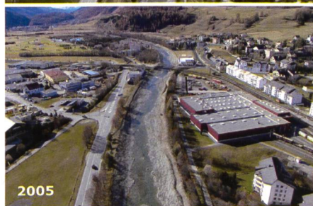
Bild 7. Linke Bildleiste: En-Kanal in Samedan (Blick von Quadratscha En-aufwärts in südlicher Richtung): Die stark reduzierte Wasserführung des En in Samedan erlaubte es, die Hochwasserdämme massiv abzusenken und damit ausreichenden Raum für Restrukturierungsmassnahmen im alten Kanalgerinne zu schaffen. Das Entwicklungspotenzial für die Massnahme erwies sich letztlich grösser, als noch bei der Formulierung und Visualisierung der Entwicklungsziele erwartet werden konnte.
