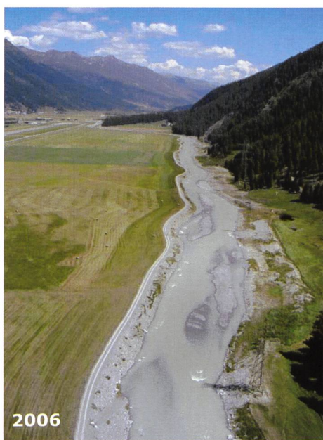
Bild 14. Der Neue Flaz: Wo 2001 noch eine Rinderweide von kleinen Drainagekanälen durchzogen wurde (Bilder rechts), fliesst heute ein von Menschenhand geschaffener, rund 4 km langer Gebirgsfluss, der Neue Flaz (linkes Bild).
