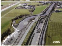
Bild 10. Rechte Bildleiste: Die En-Ausleitung (Blick En-aufwärts in südlicher Richtung): Die Ausleitung des En in das Gerinne des En-Altlaufs unterhalb Samedan war das Herzstück der gewässerökologischen Aufwertungen im System. Einige der in der Zwischenzeit durchgeführten Massnahmen sind auf dem Situationsbild von 2005 noch nicht sichtbar (z.B. Gestaltung des linken Ufers der Ausleitung; Auffüllung und Bepflanzung des alten Kanalgerinnes).
