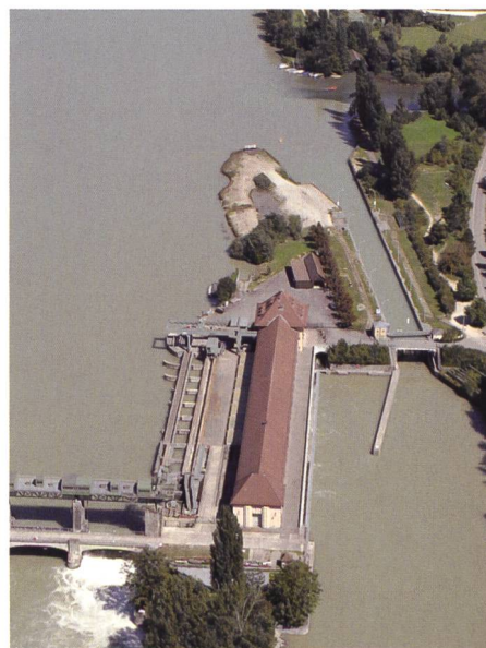
Bild 7. Schleuse Augst nach Umbau.
