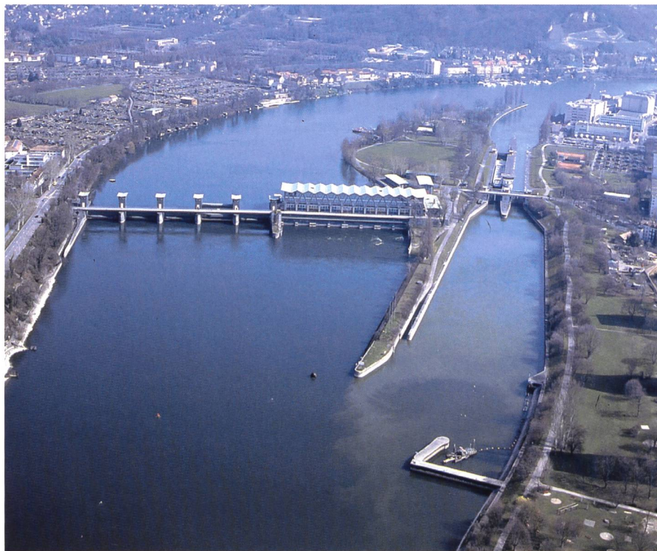
Bild 1. Stauanlage Birsfelden mit Wehr, Kraftwerk und Schleusen. Im Vordergrund die Hakenbuhne, welche den Schwebstoffeintrag vom Rhein in den unteren Vorhafen mindern soll.
