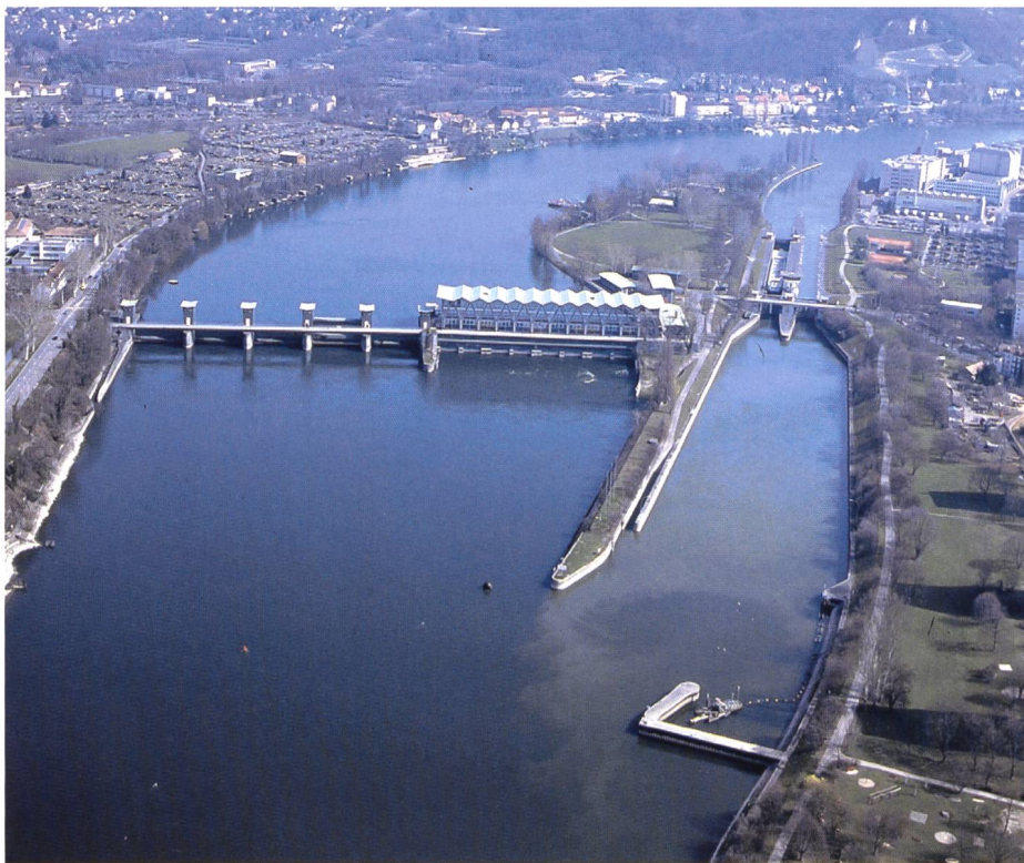
Bild 1. Stauanlage Birsfelden mit Wehr, Kraftwerk und Schleusen. Im Vordergrund die Hakenbuhne, welche den Schwebstoffeintrag vom Rhein in den unteren Vorhafen mindern soll.
