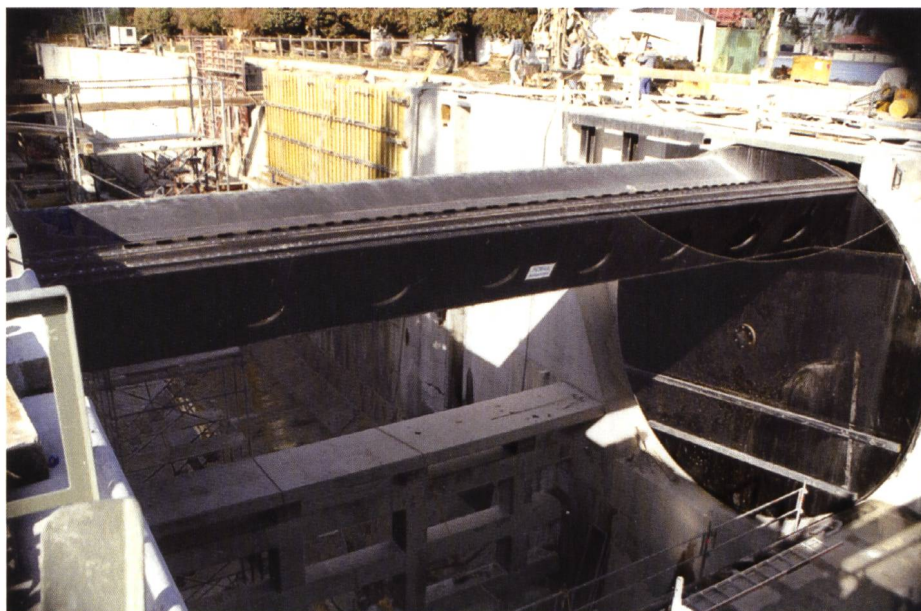
Bild 5. Drehsegmenttor Augst in Montage- oder Reparaturposition, im Hintergrund die senkrechte Schleusenwand im Bau, vorne unten die Energievernichtungswand am Obertor.
