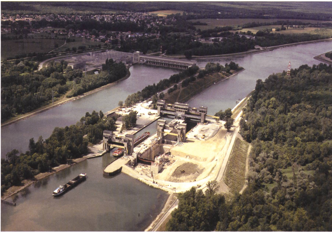
Bild 8. Luftaufnahme der Baustelle Kembs im Jahr 1998, im Hintergrund das Kraftwerk. Die grosse Schleuse blieb während der Arbeiten in Betrieb.
