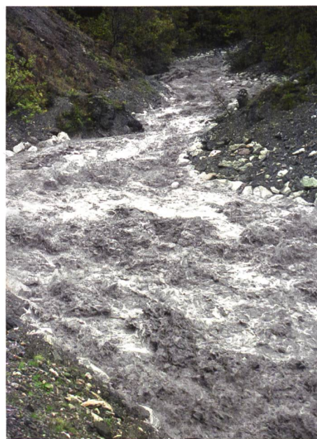
Bild 1. Naturnah gestaltete Steilstrecke an der Dala. Im linken Bild der Zustand bei Niedrigwasser (Foto VAW), rechts ist der Zustand während des Hochwassers im Oktober 2000 gezeigt.
