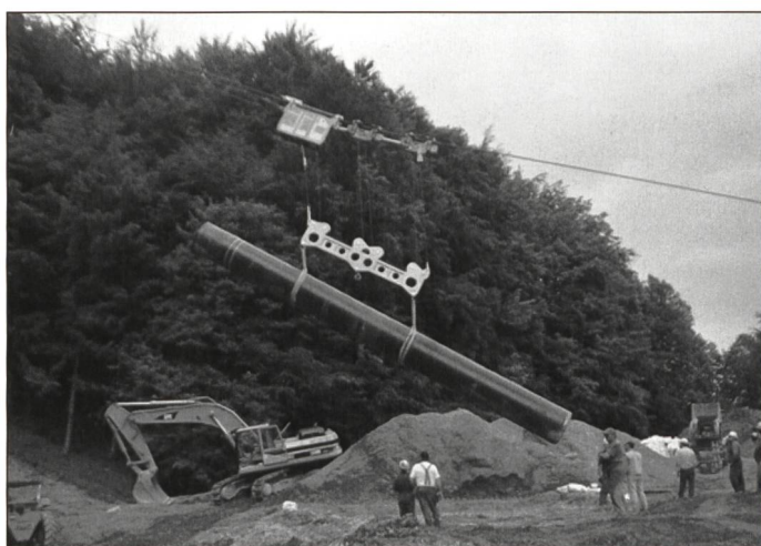
Transport und Versetzen Erdgasleitung, Rohrgewicht 12 Tonnen
