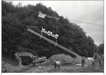
Transport und Versetzen Erdgasleitung, Rohrgewicht 12 Tonnen
