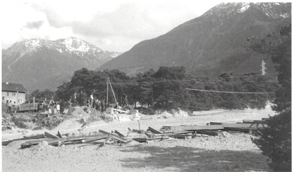
Bild 3. Der Murgang am 3. Juni 1961 zerstörte die Brücke über den Illgraben. (Kreisforstamt IV, Kt. VS).
