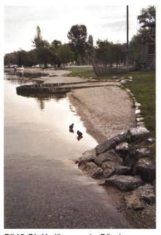
Bild 5. Die Verjüngung der Böschungsbreite gegen den Vordergrund hin hat eine übersteile Böschungsneigung. zur Folge. Die Kiesschüttung wird durch die Brandung jedoch abgeflacht, was zu einem Verlust von Material durch seitliche Verfrachtung in Richtung des Betrachters oder zu einer Unterspülung der Blockreihe an der Böschungsoberkante führt.
