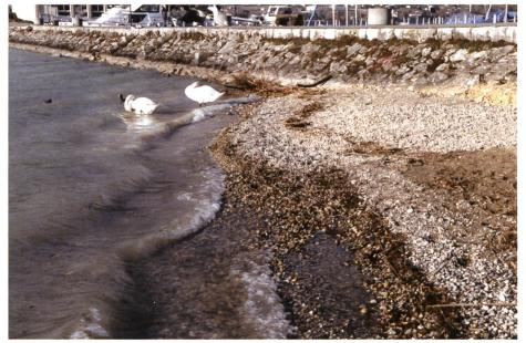
Bild 6. Eine Mole bildet den seitlichen Abschluss der Kiesschüttung. Die Wellen werden der Mole entlang jedoch beschleunigt und treffen mit erhöhter Energie auf den Kieskörper auf. Bereits kurz nach dem Einbau ist hier eine Materialverlagerung entlang des Dammfusses festzustellen. Dies führte in der Folge zu einer übersteilen Böschungsneigung, weshalb die Stelle nachträglich mit einer Pflästerung aus Blöcken gesichert werden musste.
