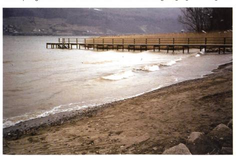
Bild 4. Je seichter die Flachwasserzone und je geringer die Schüttneigung, desto feineres Material kann geschüttet werden.
