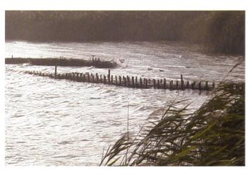
Bild 3. Wellendämpfende Wirkung von Lahnungen.
