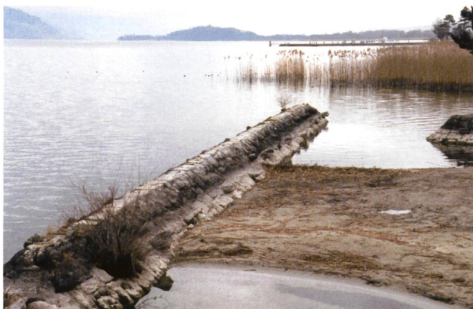
Bild 2. Durch Diffraction der Wellen am Wellenbrecher (links) bildet sich ein Tombolo (rechts).
