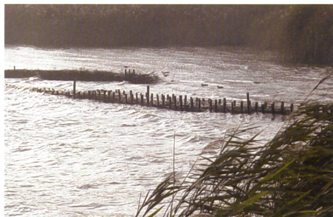
Bild 3. Wellendämpfende Wirkung von Lahnungen.
