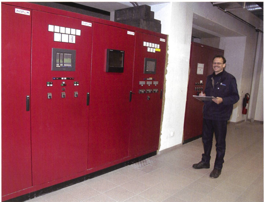
Bild 4. Kommando-Schalt- und Steuerschrank.
