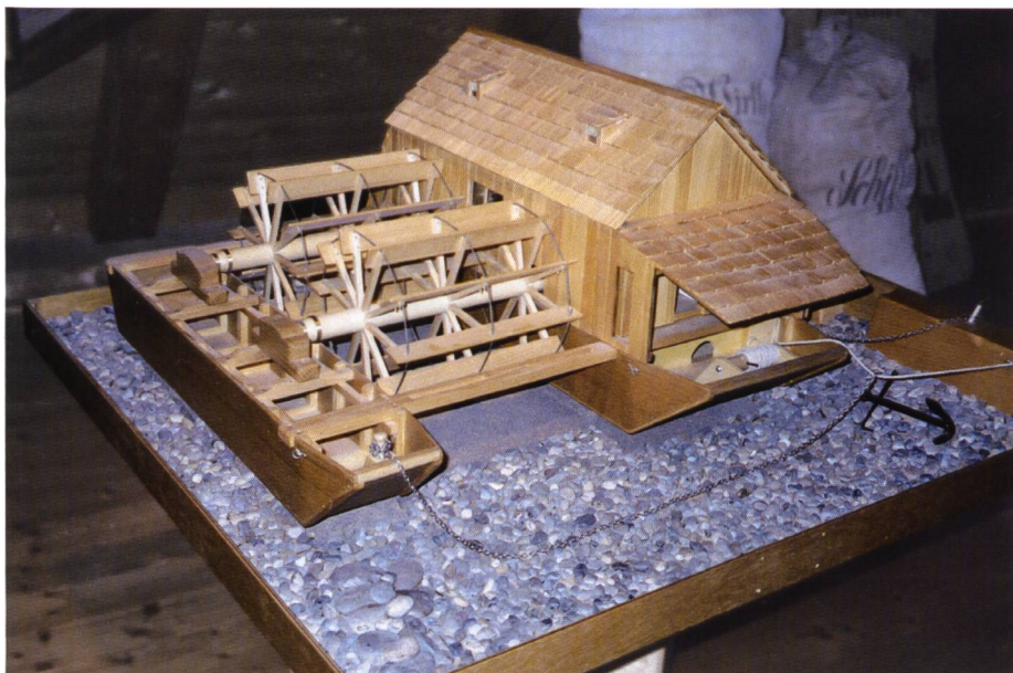
Bild 5. Rechtsufrige Schiffmühle in Egglisau, Modell im Ortsmuseum, erstellt nach historischen Bildern ab 1730 (Foto des Verfassers).
