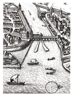
Bild 1. Die Brückenmühle in Konstanz mit Fangedämmen. Auszug aus einem Stich von M. Merian 1643, Blick in Fliessrichtung (aus Grim 1994).
