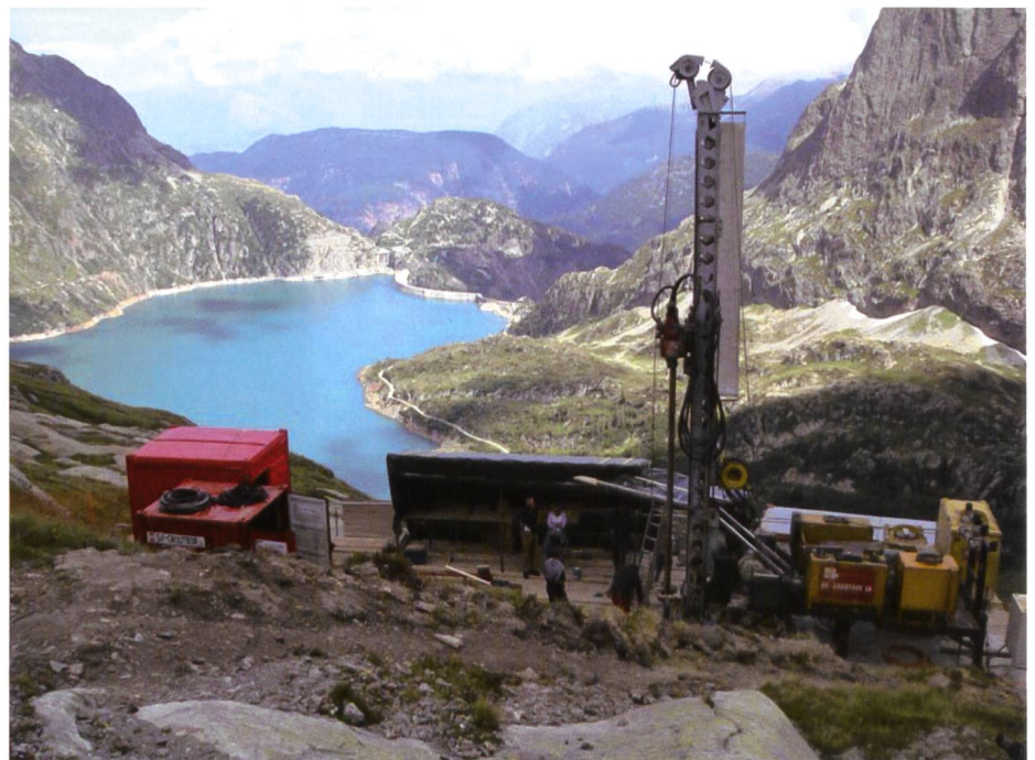
Bild 3. Bohrinstallationen Emosson – Tiefensondierbohrung im Bereich der Vertikal-schächte – im Hintergrund der Stauee Emosson.
