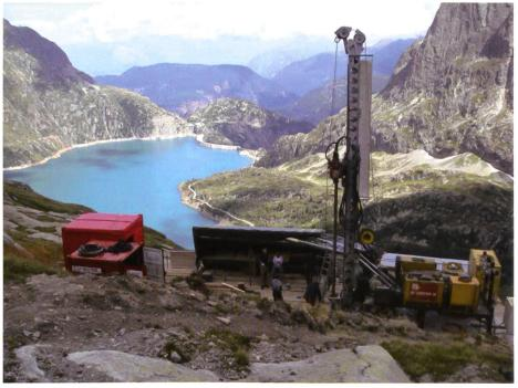
Bild 3. Bohrinstallationen Emosson – Tiefensondierbohrung im Bereich der Vertikalschächte – im Hintergrund der Stausee Emossson.
