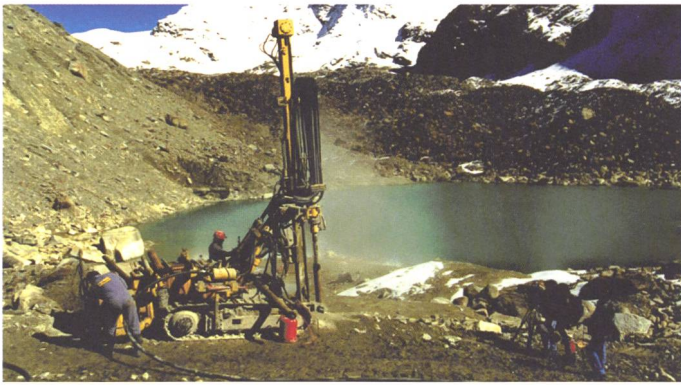
Bild 6. Verstärken des Dammes bei Grubensee Nr. 1.
