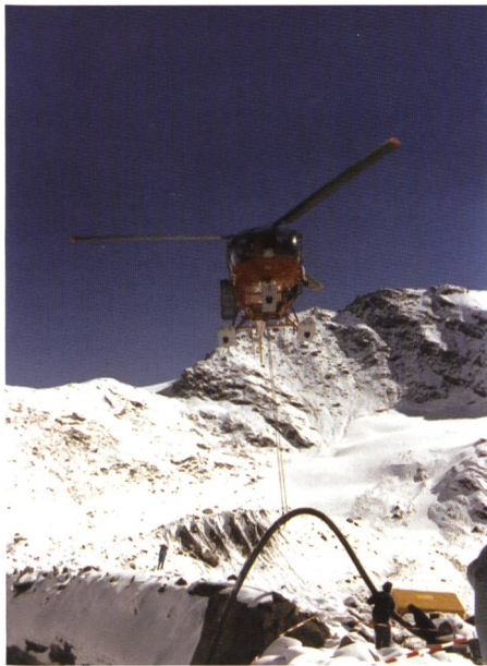
Bild 11. Auspumpen von Grubensee Nr. 5.
