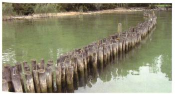
Figure 6. Photo d'une palissade utilisée sur le Lac de Bienne Pour la protection du rivage contre l'érosion.
