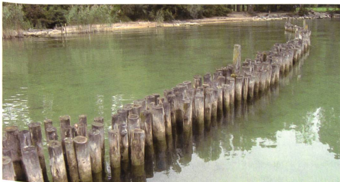
Figure 6. Photo d'une palissade utilisée sur le Lac de Bienne pour la protection du rivage contre l'érosion.
