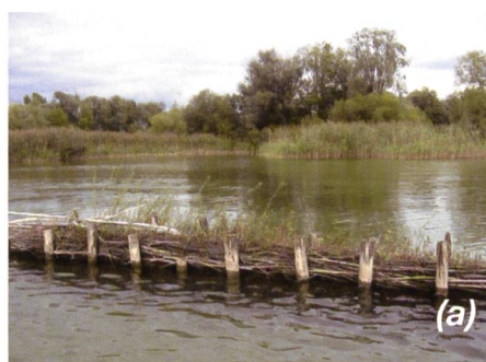
Figure 1. Protection des rives par des mesures souples: (a) protection des roselières par des barrages à claire-voie sur le lac de Bienne; (b) stabilisation par matériaux fins et épis à Bellerive sur la rive nord du Léman.
