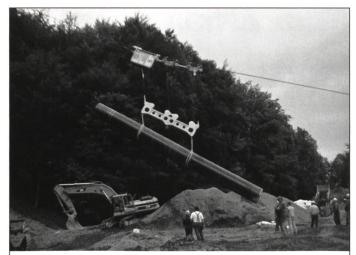
Transport und Versetzen Erdgasleitung, Rohrgewicht 12 Tonnen
