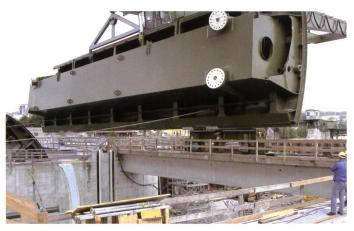
Bild 5. Segmentmontage.
