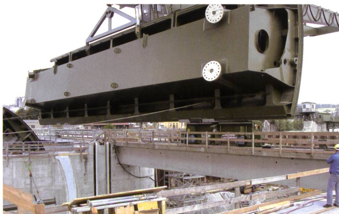
Bild 5. Segmentmontage.
