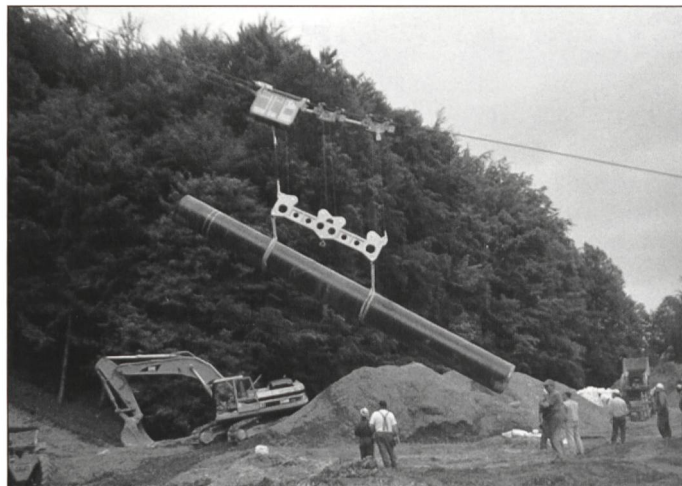
Transport und Versetzen Erdgasleitung, Rohrgewicht 12 Tonnen
