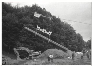
Transport und Versetzen Erdgasleitung, Rohrgewicht 12 Tonnen
