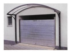
Bild 2. Hochwasserschott bei Eingang Privathaus in Sarnen OW.
