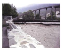
Bild 1. Eleganter Dammbau aus örtlichen Natursteinen mit Öffnung für Schneeräumung, Mitlödi GL. Gebaut durch TBF-Marti AG in Schwanden GL, abgeschottet mit Hochwassersystem Talimex AG.
