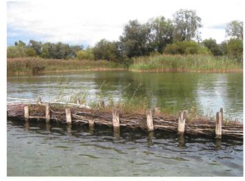
Figure 1. À gauche, érosion linéaire sur la rive nord du Léman; à droite, Protection de rive par des barrages à claire-voie sur le lac de Bienne.
