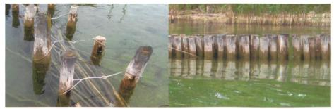
Figure 12. À gauche, détail constructif de barrage à claire-voie sur le lac de Bienne; à droite, exemple de palissade à deux rangées de pieux.
