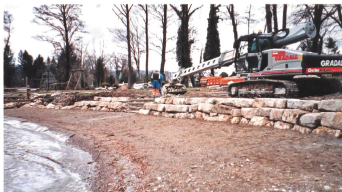
Bild 2. Aufwertung einer Badebucht durch Kies/Sand-Vorschüttung, kombiniert mit dem Schutz prähistorischer Kulturschichten durch Blocksatz (Strandplatz Sutz).
