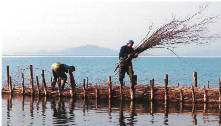
Bild 3. Bau einer Lahnung zum Schutz von Schilfbeständen (Mörigen).
