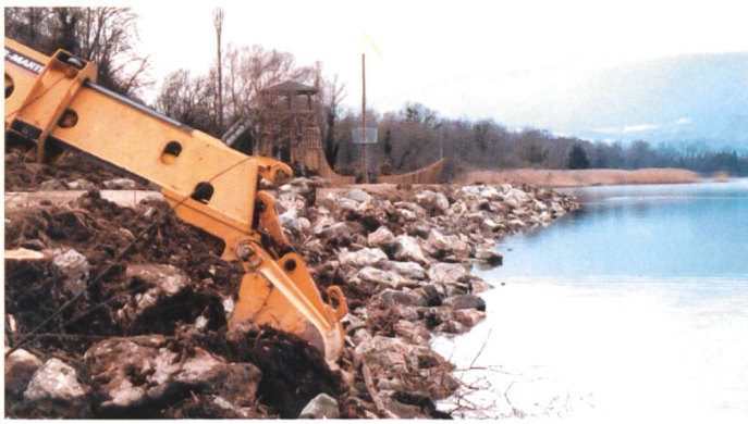
Bild 4. Rückbau eines Blockwurfs (Strandbad Erlach).
