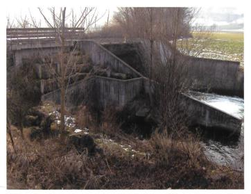
Bild 5. Das Kleinwasserkraftwerk in Lotzwil (bei Langenthal) nutzt eine kleine Geländestufe zur Erzeugung erneuerbarer Elektrizität.
