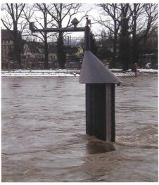
Bild 3. Dalben im Rhein bei Rheinhalle (rechtsufrig bei Rhein-km 164,27) mit der darauf montierten Radarmessanlage anlässlich des Hochwassers vom 9. März 2006, Pegelstand 248,10 m, Abflussmenge knapp 2700 m³/s. (Foto F. Stoller, BAFU).
