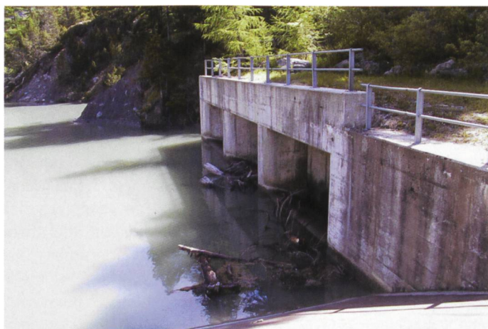
Bild 8. Einlauf der Hochwasserentlastung mit Schwemmholz.
