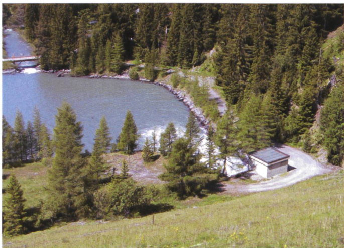
Bild 4. Grundablassschützenkammer mit Beruhigungsbecken.
