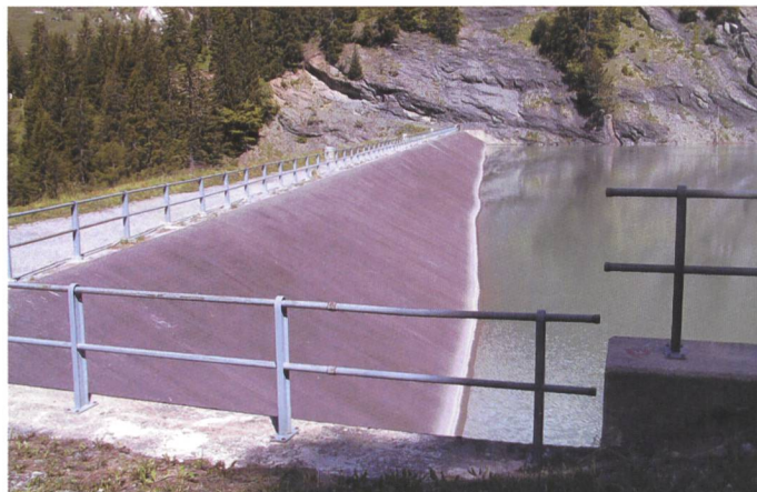
Bild 3. Oberwasserseitige Dammböschung mit rechtem Widerlager.
