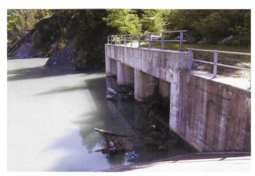
Bild 8. Einlauf der Hochwasserentlastung mit Schwemmholz.
