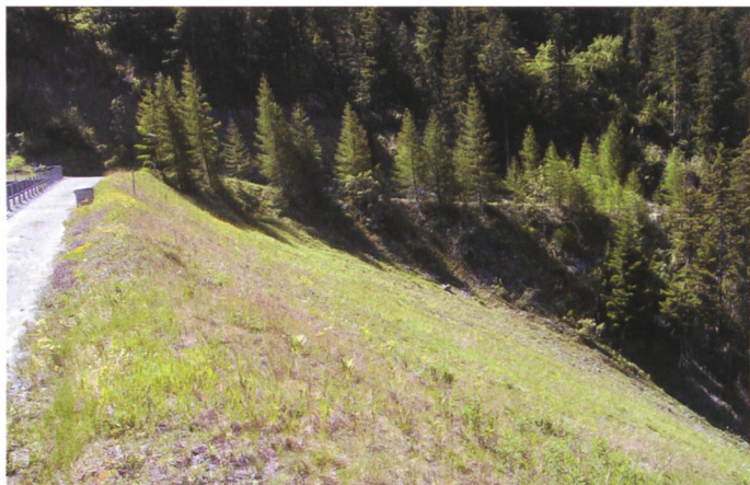
Bild 2. Linkes Dammwiderlager mit luftseitiger Böschung.
