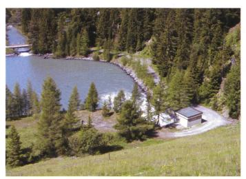
Bild 4. Grundablassschützenkammer mit Beruhigungsbecken.
