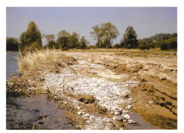
Bild 12. Juni 1995: das Hochwasserbett der Thur ist abgetragen und abgesenkt worden.
