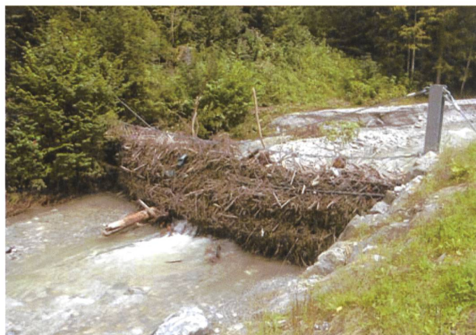
Bild 9. links: Seilnetzsperrung Burgleitenbach, Lkr. Weilheim-Schongau; rechts: Seilnetzsperrung Kanker, Lkr. Garmisch-Partenkirchen.
