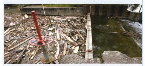
Bild 5. Senkbalken beim Ausfluss eines Geschwemmselbeckens.
