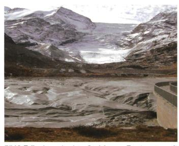
Bild 8. Teilweise verlandeter Speicher von Tourtemagne mit Gletscher im Hintergrund.
