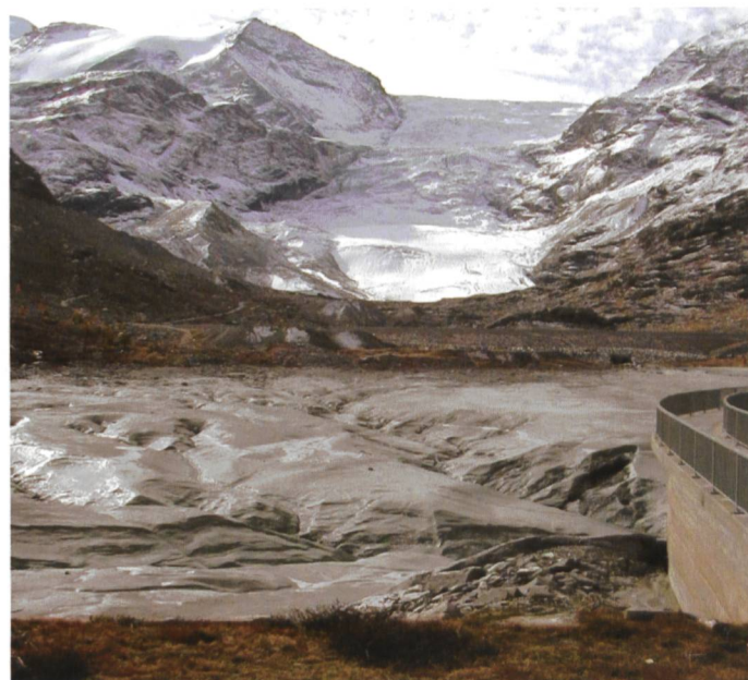
Figure 6. Ensablement du barrage de Tourtemagne.
