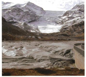
Figure 6. Ensablement du barrage de Tourtemagne.
