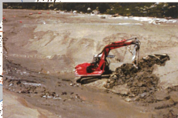
Figure 13. A gauche: Disposition des tas dans la retenue pour le curage du bassin; à droite: augmentation de l'efficacité du curage par déplacement des matériaux solides à l'intérieur de la retenue à l'aide de moyens mécaniques (photo: D. Job, Colenco).
