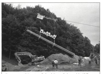
Transport und Versetzen Erdgasleitung, Rohrgewicht 12 Tonnen
