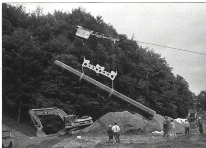
Transport und Versetzen Erdgasleitung, Rohrgewicht 12 Tonnen
