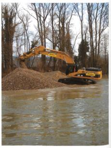
Bilder 1 bis 3. Aus der Reuss wird hochwertiger Kies gefördert und so gleichzeitig der Hochwasserschutz wieder hergestellt.
